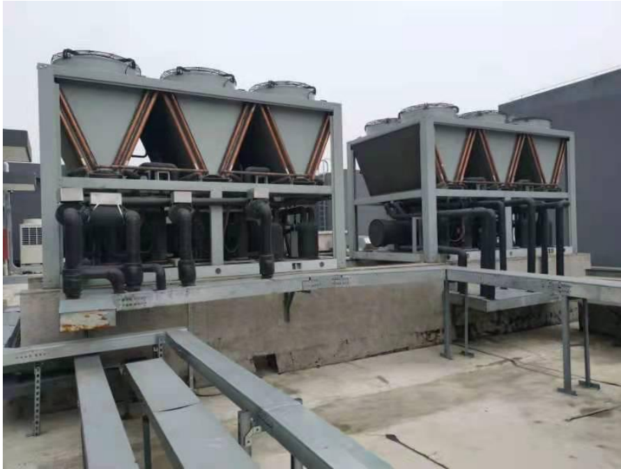
中国电信苏州太湖国际信息中心智能化动态调节空调室外主机
