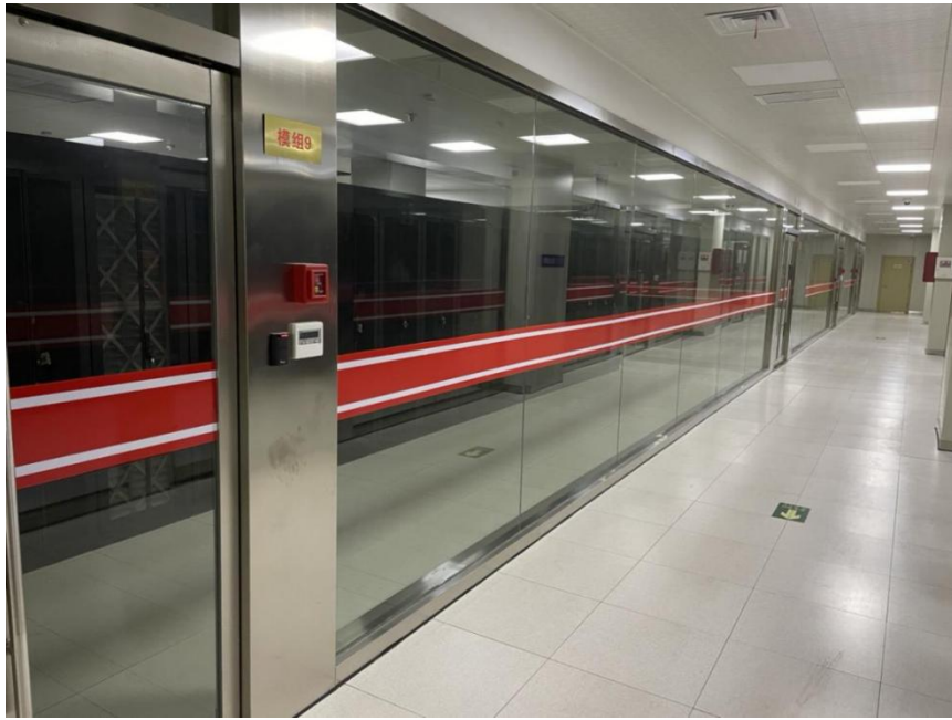
绍兴市行政中心中心机房模组机房
